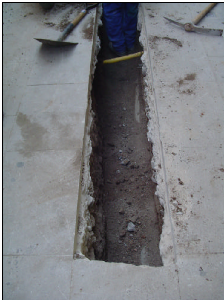
Foto 7: Rebaix efectuat al carrer del Correu Vell.
