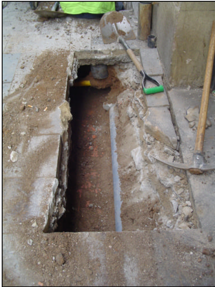
Foto 6: Detall del rebaix efectuat al carrer Regomir núm. 6.
